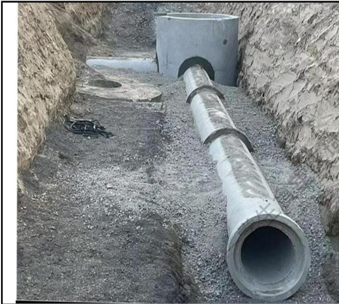
管道安装示意图
